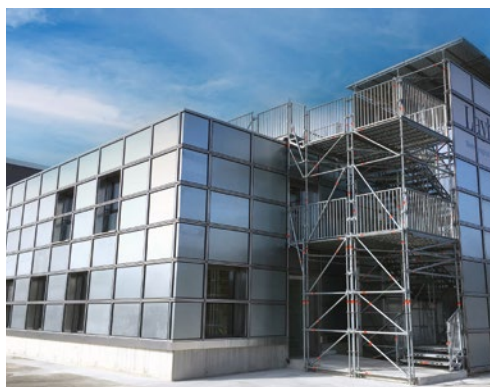
Schulungszentrum West (Foto: Layher)
